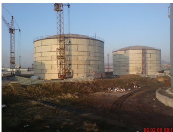
Фиг. 7. Изграждане на стените на резервоарите
