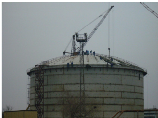
Фиг. 8. Монтаж и заваряване на покривите
