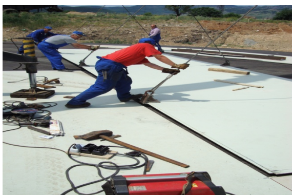
Фиг. 6. Монтаж и заваряване на дъната на резервоарите
