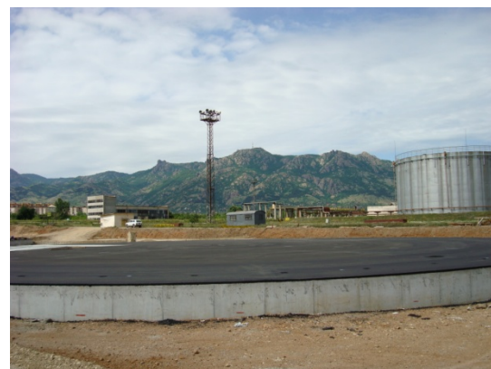
Фиг. 5. Изграждане на фундаменти
